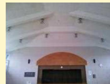
大規模地震に備えるために、体育館天井等の落下防止等の工事を夏季休業中に行うことになりました。天井パネルを取り外したり、鉄骨を塗装したり、照明をLEDに交換したりする大がかりな工事です。工期完了が8月末のため、夏休み中は体育館は使用できません。また、体育館周りを閉鎖するため、移動にも制約が生じます。ご不便をおかけしますが、ご理解くださいますようお願いいたします。
